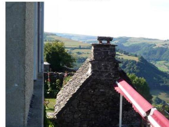
Les souches de cheminée sont appareillées à double degré et larmiers moulurés d'une gorge, sur la face de laquelle est imbriqué le solin en pierre de la toiture initiale de la demeure.
