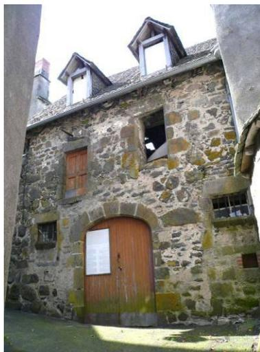
Grange-étable à un étage du XVIII<sup>e</sup> siècle de plan rectangulaire. La construction est sise le long d'une venelle reliant la rue de la Martille à la rue des templiers. Sa maçonnerie est en appareil de moellons grossiers de dimensions très variées de brèche et de basalte disposé en *opus incertum*.
